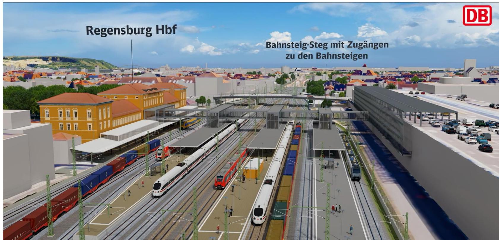
Im Bereich Regensburg Hbf wird ein neuer Mittelbahnsteig zwischen dem bestehenden und dem Einkaufszentrum errichtet. Der Zugang erfolgt vom bestehenden Verbindungssteg und wird barrierefrei erschlossen. An diesen Bahnsteig wird das Südgleis aus Richtung Donautalbahn herangeführt.
