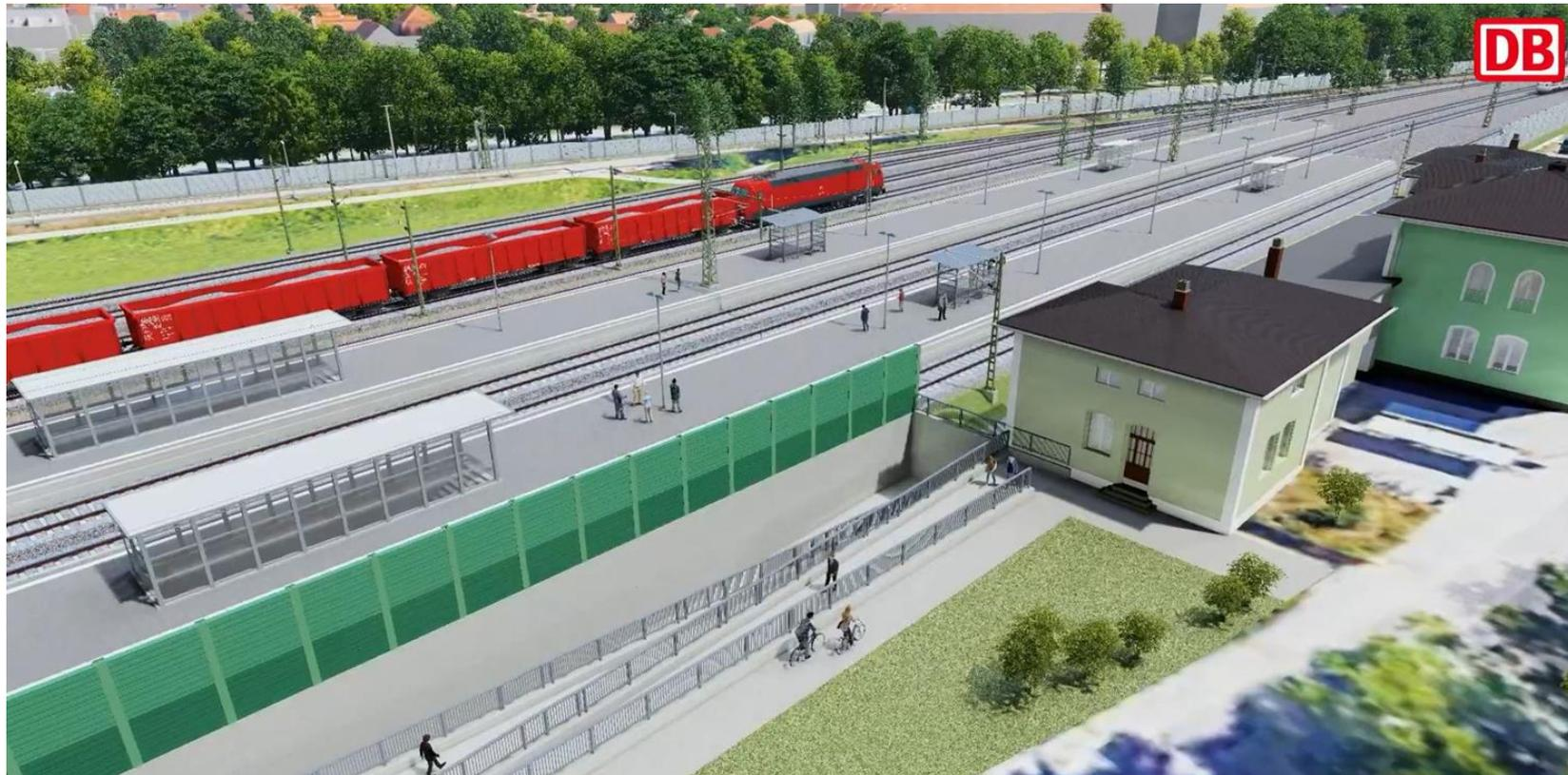
Die Verkehrsstation Prüfening wird barrierefrei ausgebaut. Eine Rampenanlage und 2 Aufzüge erschließen die beiden neuen Mittelbahnsteige. Die Zugangsanlage zum Bahnsteig wird 6 m breit und 3 m hoch.
