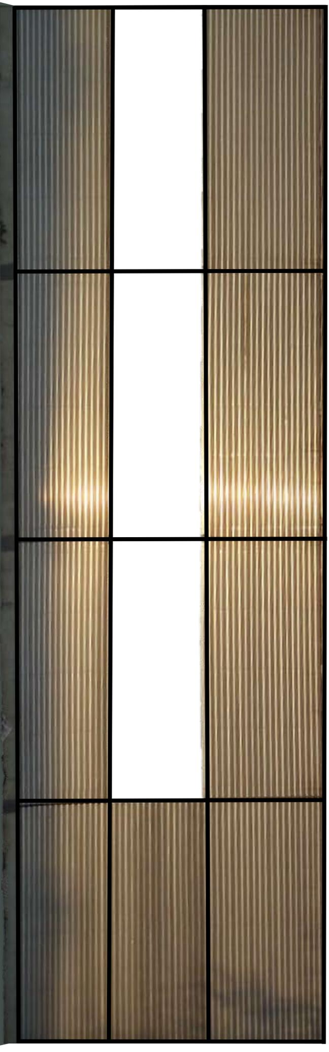
U-Profil 80x46x3,8    IPE Träger 80x46x3,8    18 / 76 / 0,70 Aluminiumwelle,    Betonfundament
